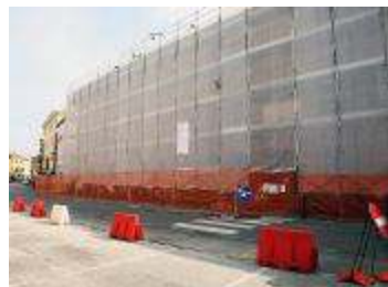
L'intervento in corso
