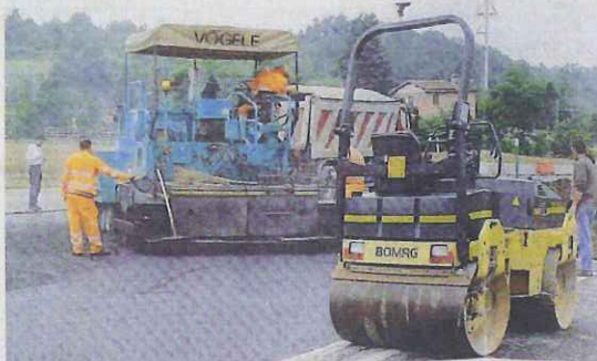
OPERE PUBBLICHE Finalmente la ristrutturazione dell'intera area è stata completata
